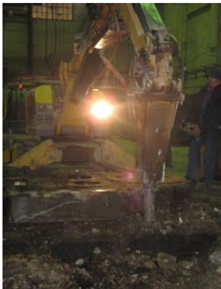
Рис. 3. Разрушение бетонных конструкций при помощи машины Brokk-330
