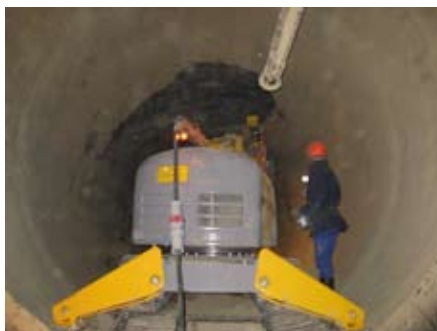
Рис. 1. Удаление огнеупора во вращающейся печи при помощи машины Brokk-330
