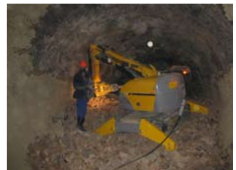
Рис. 2. Машина Brokk работает, располагаясь на околу
